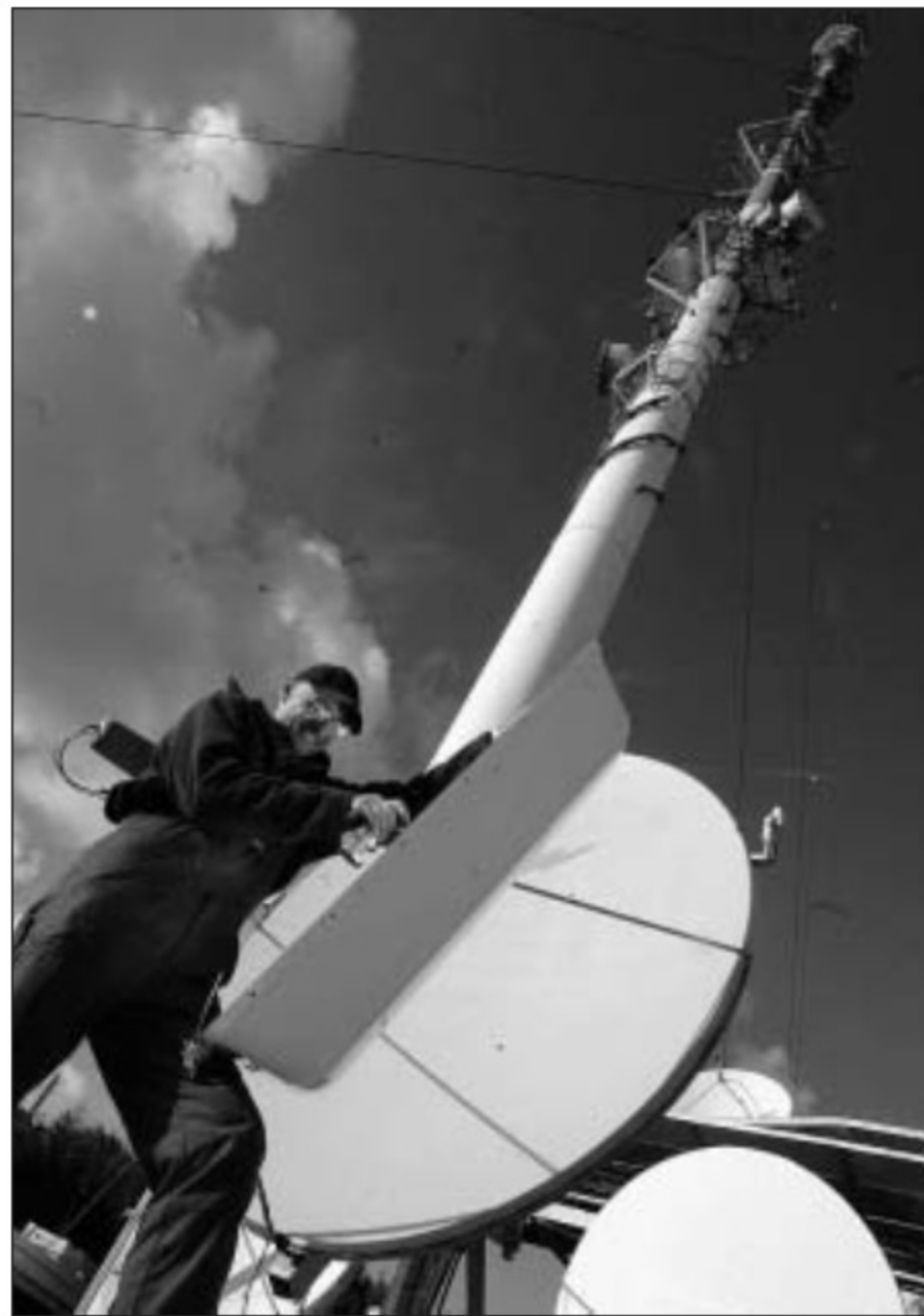
Au mont des Cats, de nouvelles antennes sont fixées au pylône.
